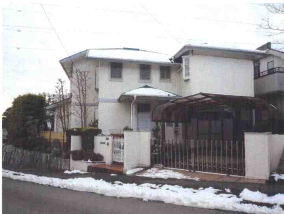
① 本件土地・建物の外観（北東側から撮影）
