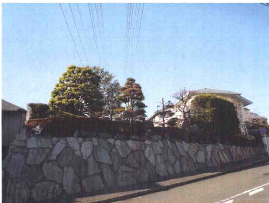
② 本件土地・建物の外観（南東側から撮影）
